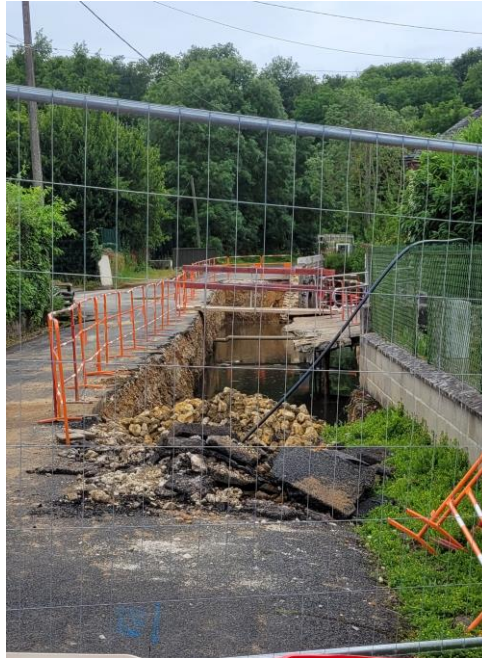
Mur du bief
