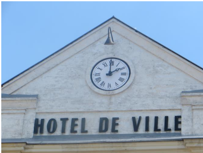
L'horloge en façade a été remplacée. Dorénavant, elle indique l'heure exacte...
